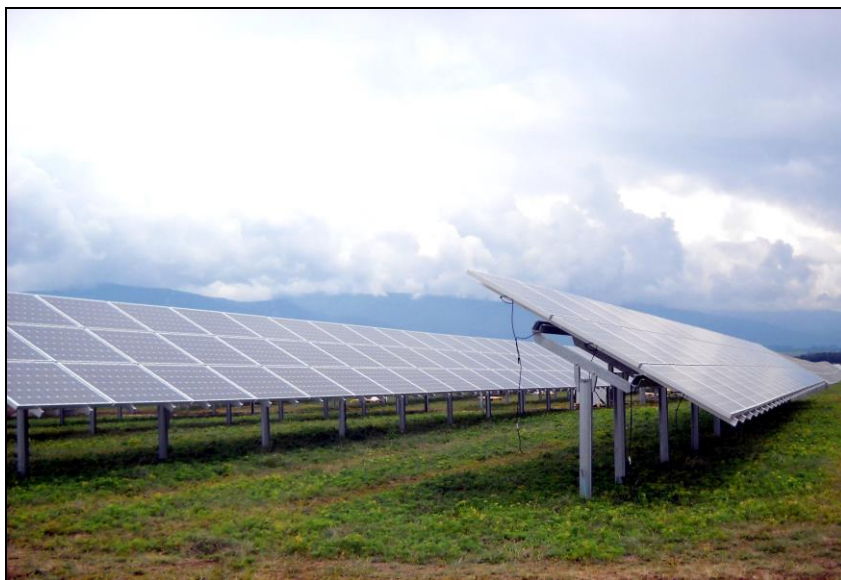
Снимка № 1 Разстояние между фотоволтаичните панели
